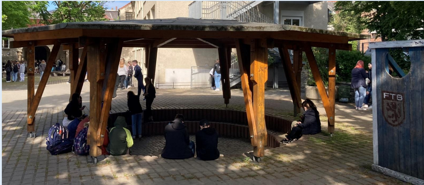
Pavillon und Torwand
